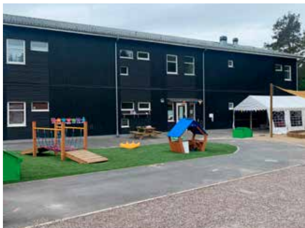
I anslutning till Bråta Allé byggde Dibbers ny förskola 2019
