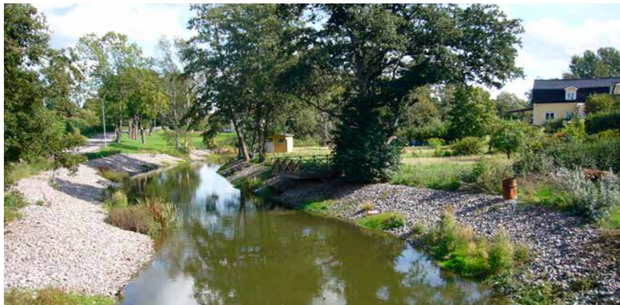
Kommunen ser kontinuerligt över kajskoning och åstränder som en del i det långsiktiga klimatanpassningsarbetet som pågått sedan länge
