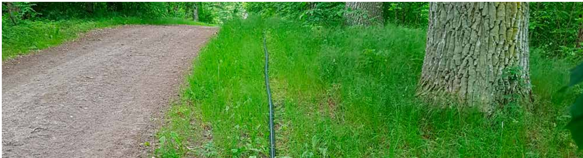
Att arbeta med dricksvattnet på långsikt är en viktig fråga och ett prioriterat område här läggs en ledning med dricksvatten ut när brunnen sinade på Tureholm
