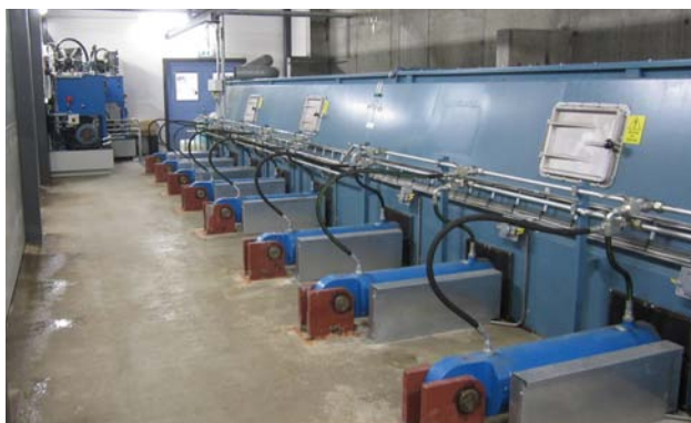
Statkrafts fjärrvärmeanläggning i Trosa.
