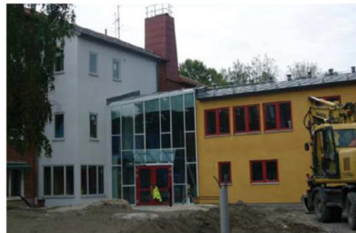
Pågående byggnation, Vitalisskolan.
