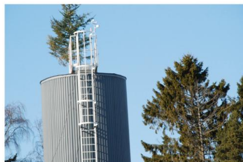
Trosa reningsverk byggs om för ökad kapacitet.
