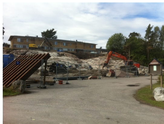
Pågående byggnation Trosalundsberget
