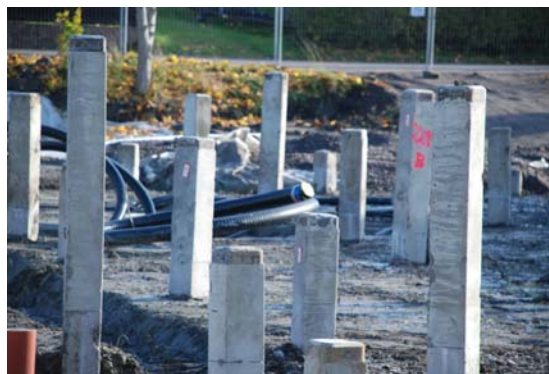
Pålningsarbete vid Skärlagsparken
