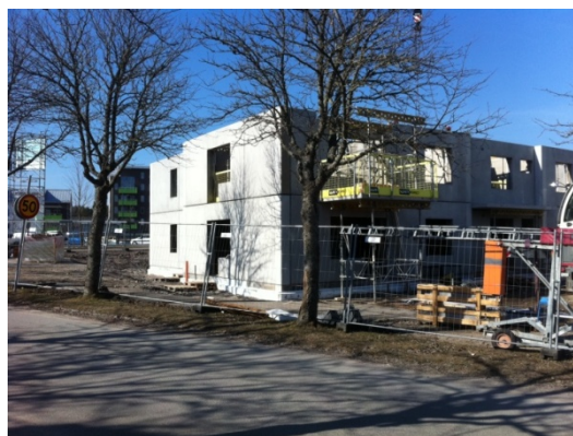
Byggnation Biblioteksvägen, Vagnhärad
