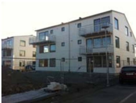
Byggnation kv. Mejseln, Trosa
