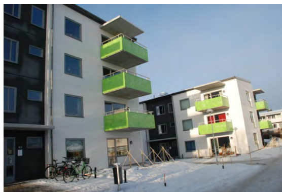
Byggnation Biblioteksvägen, Vagnhärad
