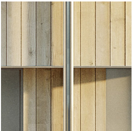
Stuprör och plåtdetaljer
