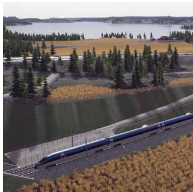
Ostlänken Hillestalund mot Sillen
