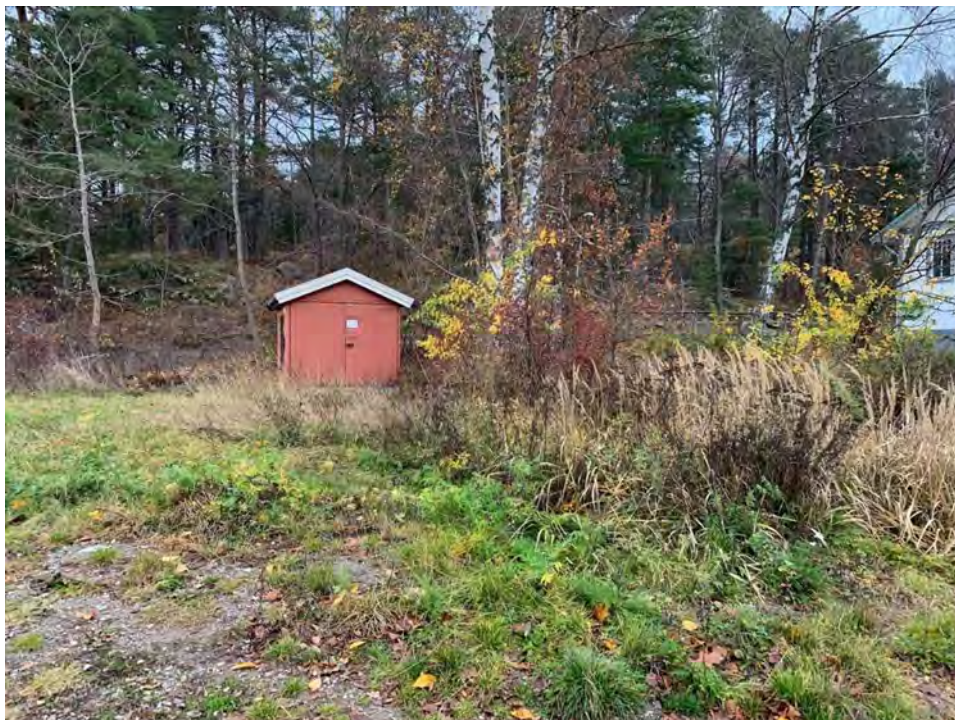
Figur 5. Befintlig transformatorstation inom planområdet.
