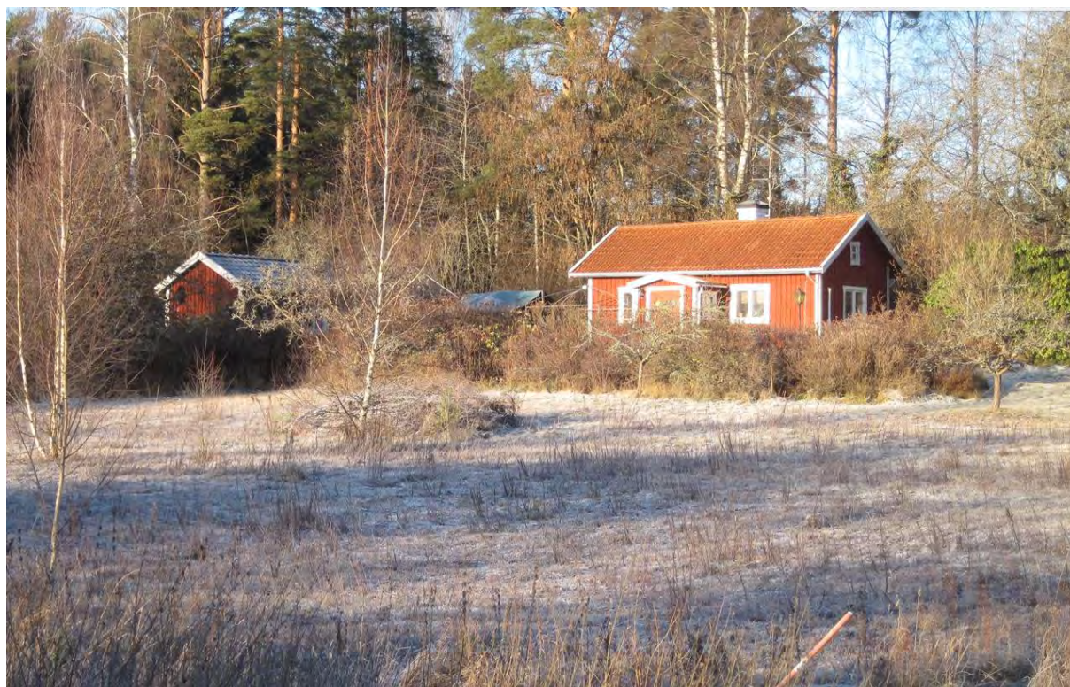
Vy över fastigheten med byggnader från väg 782 mot norr.
