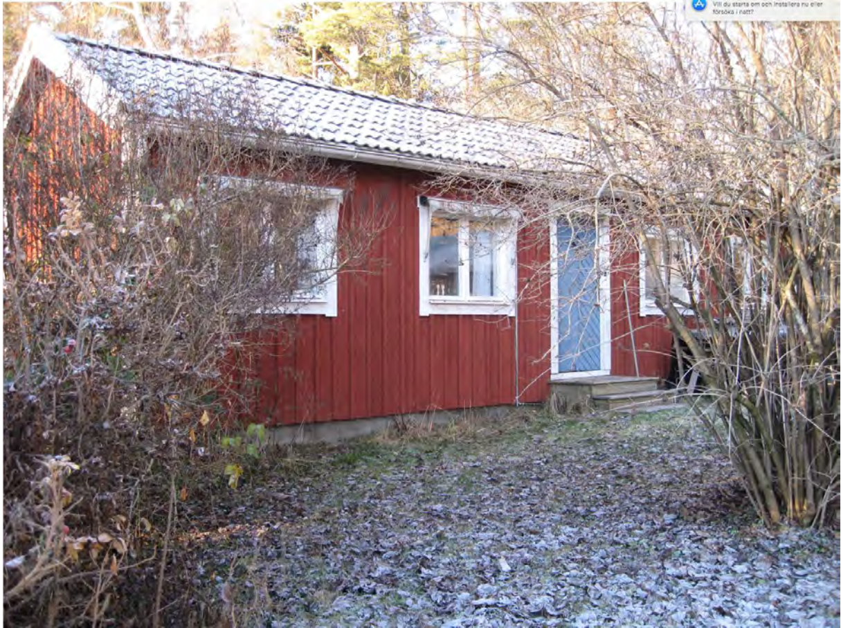
Den yngre komplementbyggnaden
