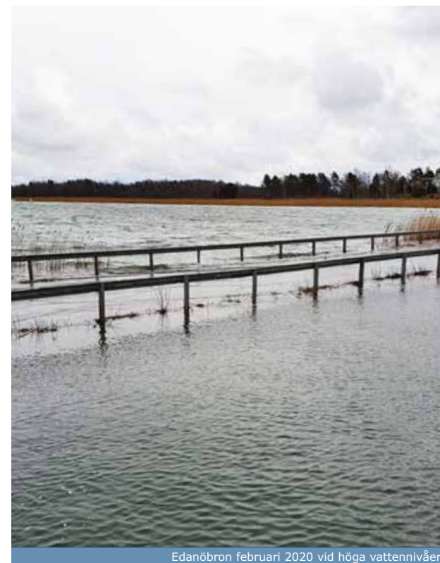
Edanöbron februari 2020 vid höga vattennivåer
