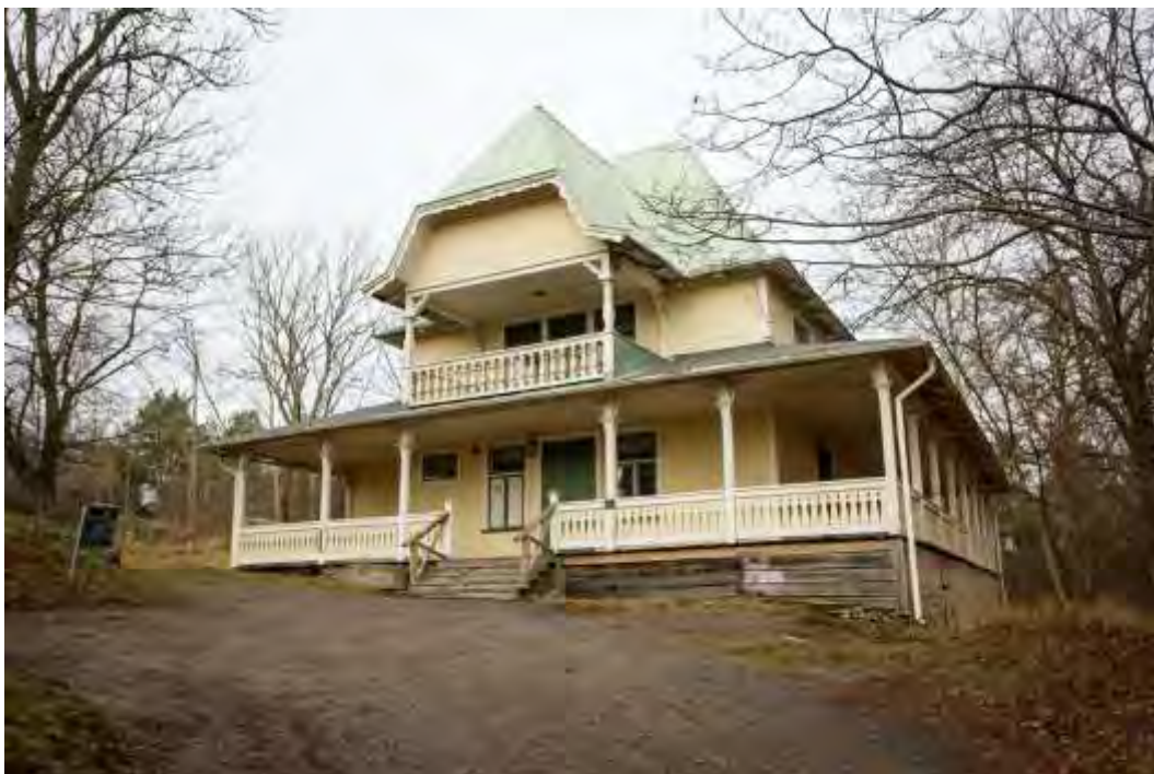
Södra fasaden på Societetshuset på fastigheten Utsikten 5 (Erika Stenlund)
