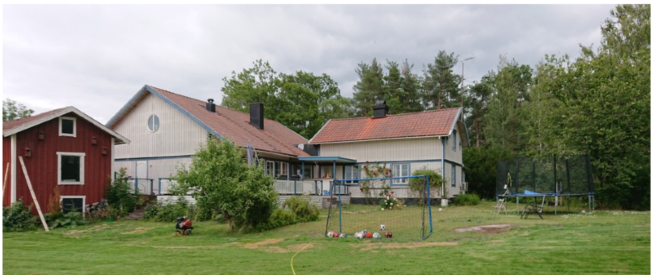
Befintligt bostadshus med del av den äldre förrådsbyggnaden till vänster och berg i dagen till höger.
