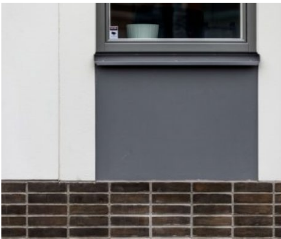
Figur 14: Exempel över elementskarvar som dölts i en medveten utformning
