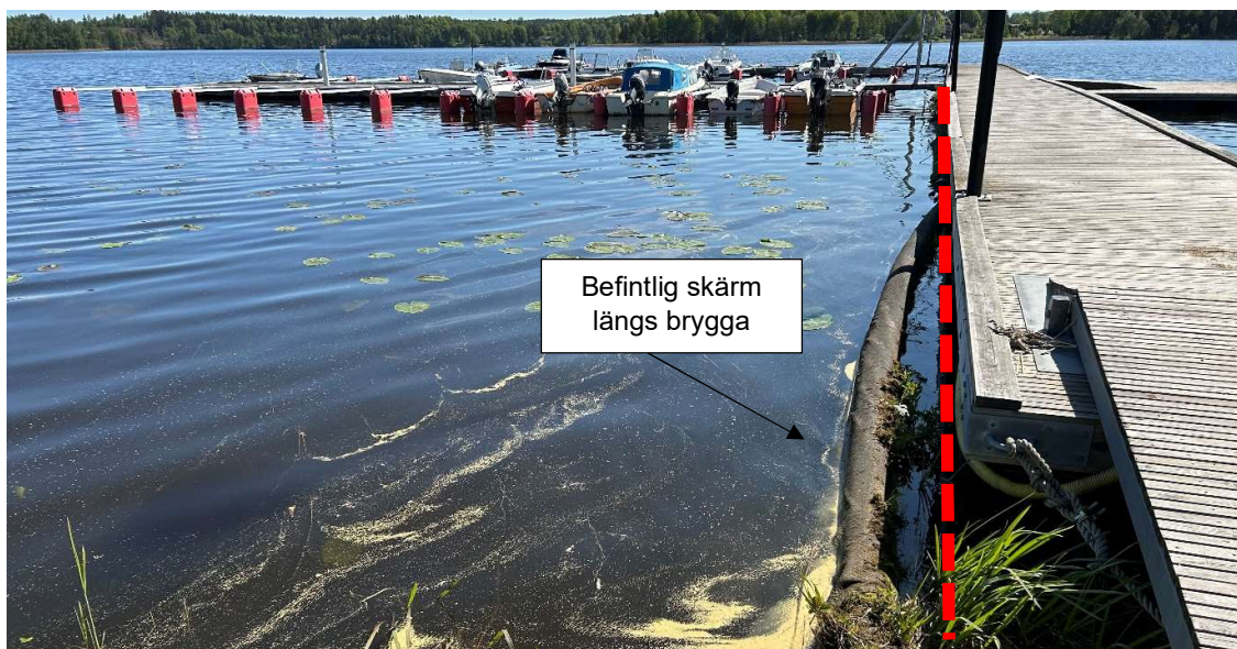
Figur 4-1. Befintlig skärm längs bryggan mellan badplatsen och småbåtshamnen. Röd linje visar skärmens längd. Det gula på vattenytan är inte algblooming utan är troligen pollen. Foto: Norconsult Sverige AB.
