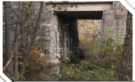
Järnvägsbron vid Holmby reningssverk. Foto; Bertil Karlsson
