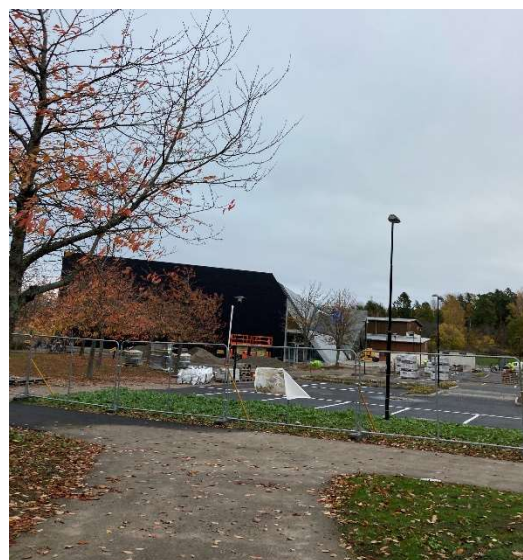
Pågående byggnation av idrottshall i Trosa
