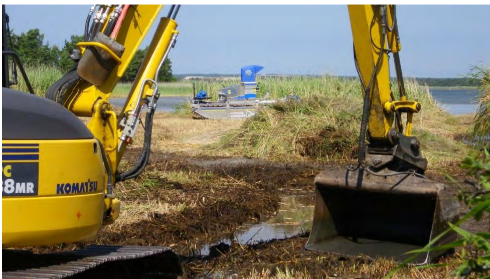
Figur 17. Att klippa vass i mynningsområden i kombination med att försiktigt öppna upp en mynning som helt slammat igen är bra åtgärder för att återställa tidigare fungerande lekområden och öppna vandringsvägarna till tillrinnande vattendrag. Foto: Lars Vallin
