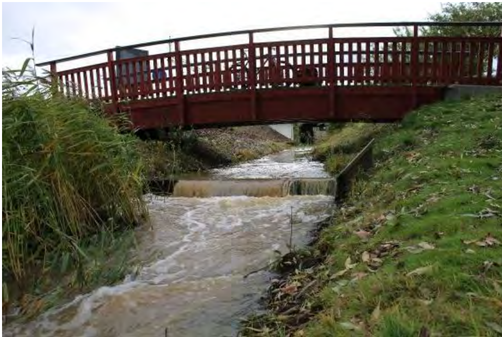
Figur 140. Direkt uppströms Marieströms utlopp till Frösjön finns ett lågt vandringshinder. Detta vandringshinder kan enkelt åtgärdas genom att det trösklas upp med grus och sten nedströms.
