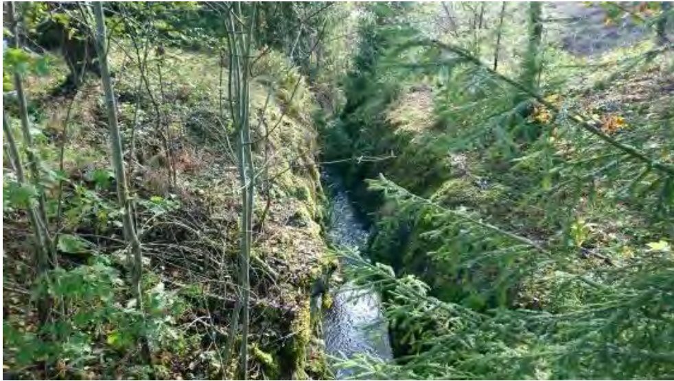
Figur 84. Direkt nedströms grusvägen som leder till Buddsjön-Masjön är bäckbotten sprängd ned i berget. Direkt efter vägen blir vattendraget kulverterat.
