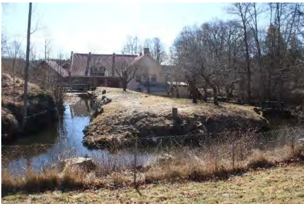
Figur 106. Uppströms Mölnbo kraftstation delar sig vattendraget i två delar. Den ena fåran leder in i kraftstationen medan den andra fåran leder till en spillkanal. Med relativt enkla medel skulle spillkanalen kunna göras om till ett omlöp vilket skulle ge fria vandringsvägar för fisk och andra organismer i vattendraget.
