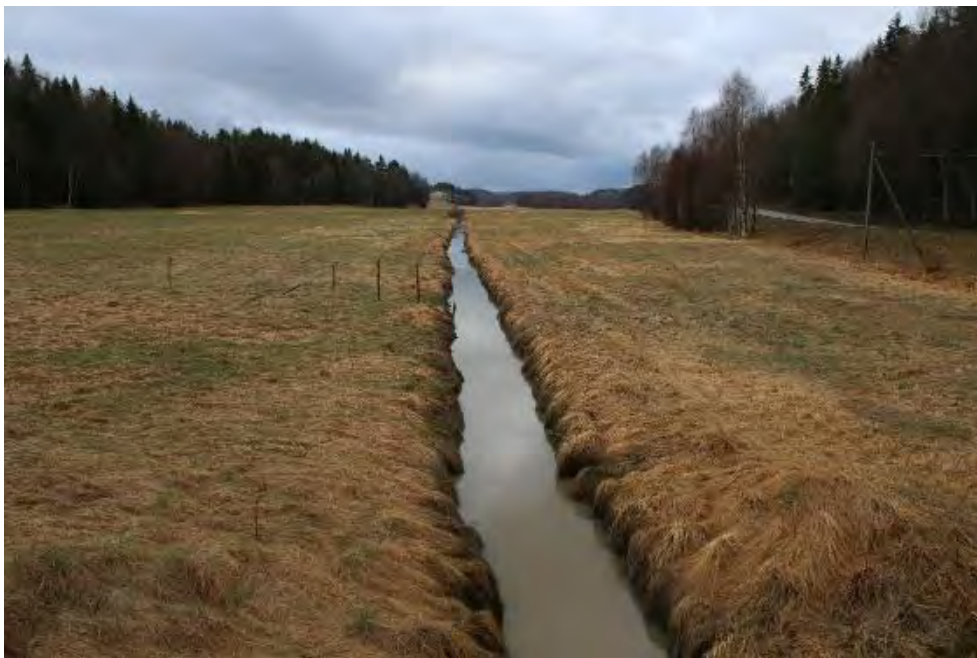
Figur 40. Stora delar i avrinningsområdet nedströms väg 224 är kraftigt rätade och rensade som ett resultat av det aktiva dikningsföretaget i vattendraget.
