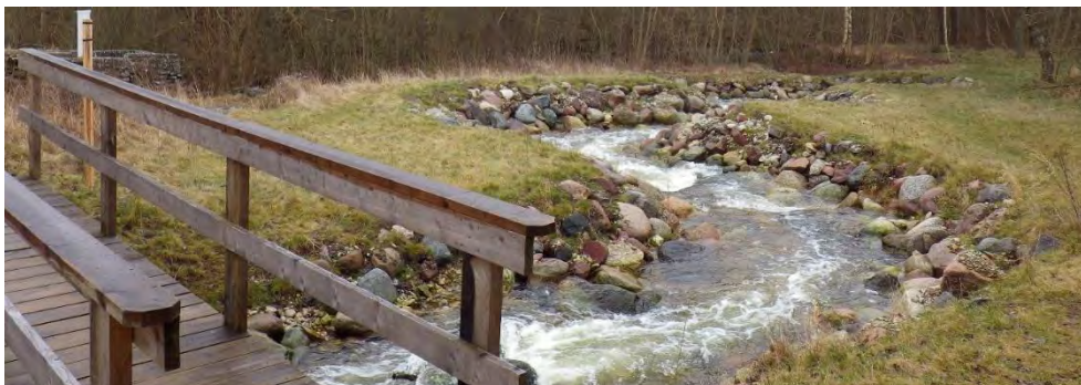
Figur 11. Ett omlöp leder vattnet i en ny fåra runt ett vandringshinder. En del av det ursprungliga hindret skymtar i form av betongkasunen till vänster i bild.
