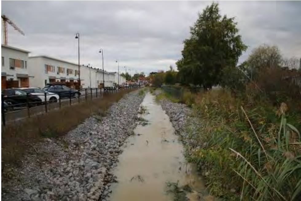
Figur 147. Där Valasjögraven rinner igenom bebyggelse närmast Frösjön liknar vattendraget mest ett dagvattendike med slänter och botten av makadam med låg beskuggning. Under en lång sträcka är vattendraget kulverterat under Gnesta samhälle.
