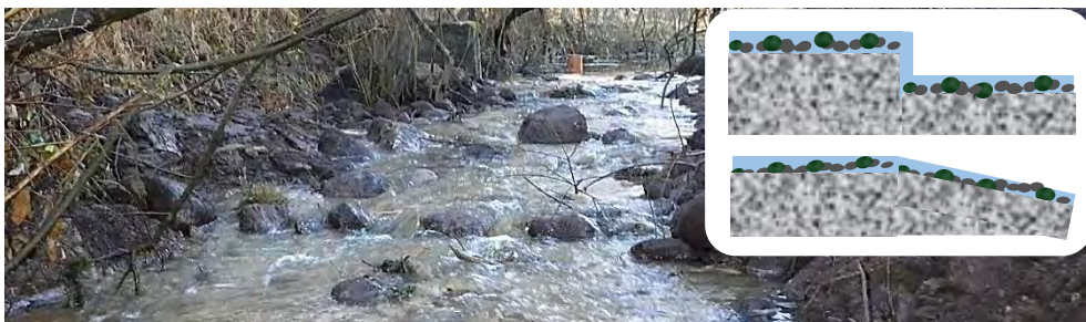
Figur 10. Samma plats som i figur 9 efter att vandringshindret åtgärdats genom tröskling. Skissen till höger visar principen för en tröskling av ett vandringshinder, där det är viktigt att den nya bottenbädden inte släpper vatten rakt igenom vilket blir följden vid användning av för grovt material och bristfällig markberedning. Foto: Lars Vallin
