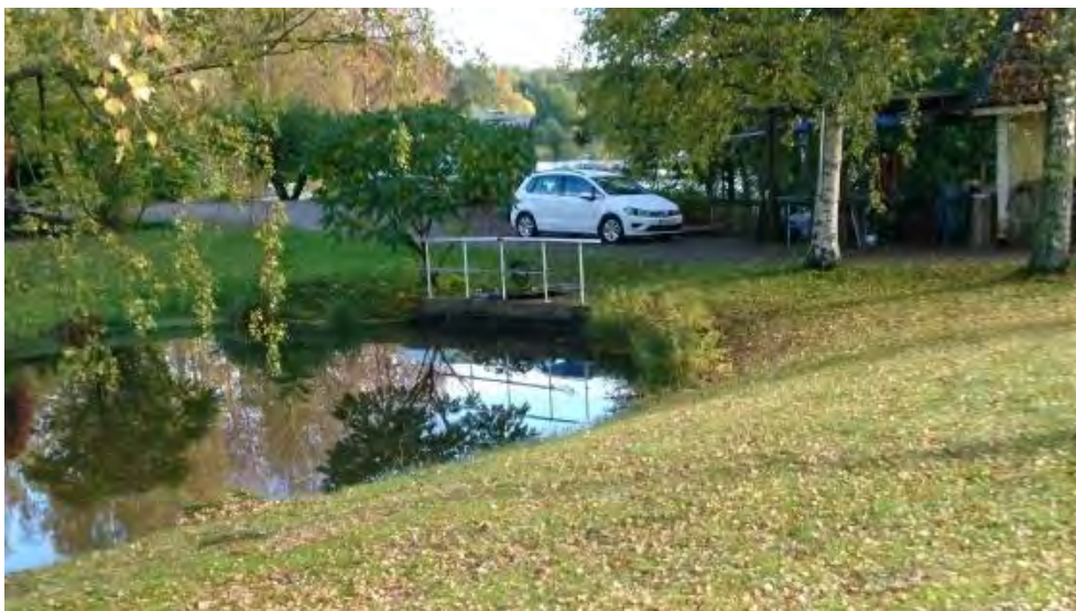
Figur 69. Dämmet vid Kvarndammen (Hedsjön) sett ovanifrån. Dämmet avvattnas via ett turbinrör som släpper vatten med ett meterhögt fritt fall på nedersidan av dämmet och således utgör ett definitivt vandringshinder för alla vattenlevande organismer. Nedströms dämmet ligger Övre Malmtorpsdammen.
