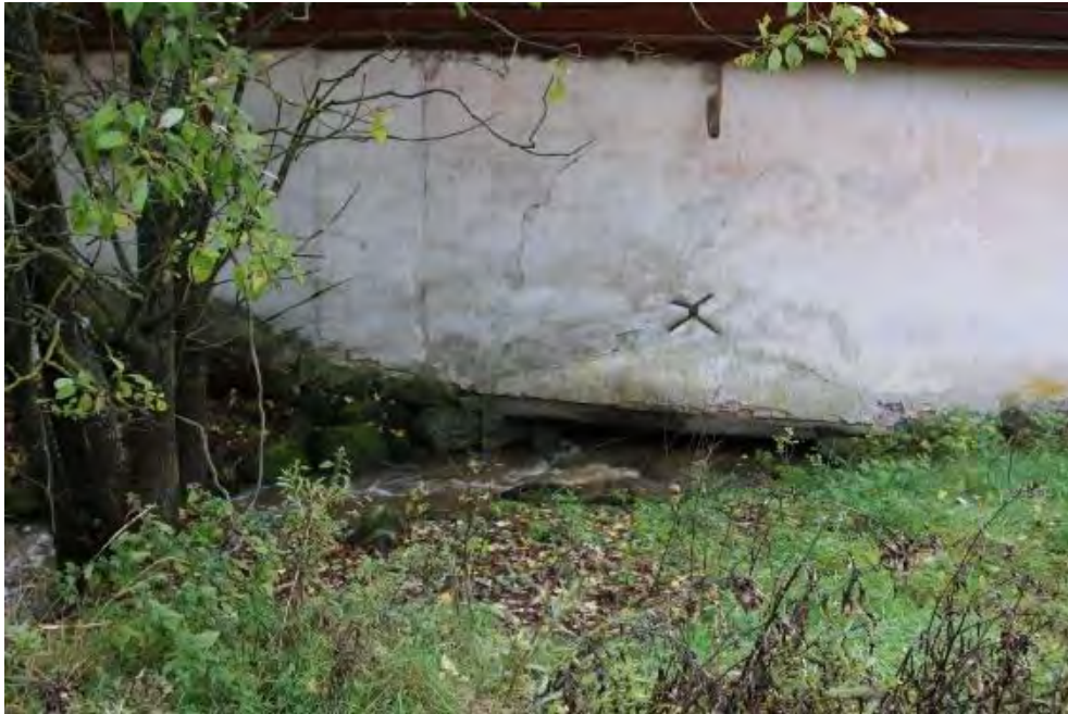
Figur 57. Cirka 250 meter uppströms bäckens mynning till Sillen ligger en byggnad som står tvärs över bäcken. Byggnaden är i sig själv inget vandringshinder i vattendraget utan bäcken flödar fritt igenom byggnaden.
