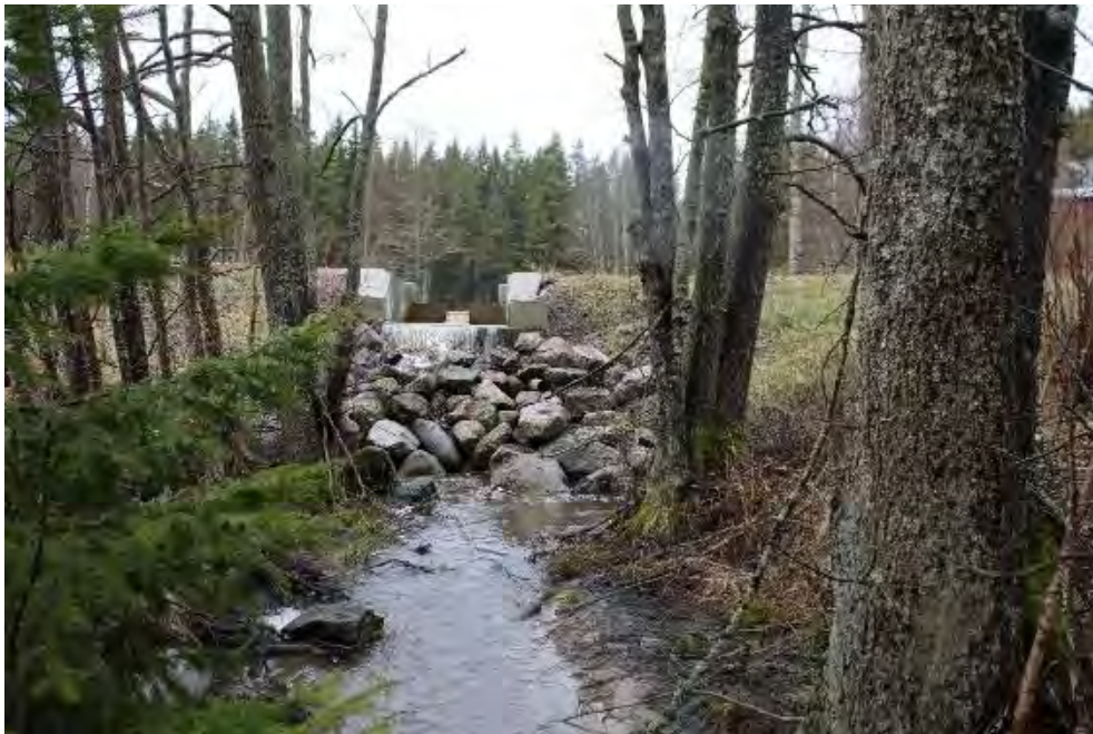
Figur 49. Vid Dalsjö strax uppströms där vattendraget passerar under grusvägen står en nyanlagd betongdamm. Dämet utgör ett definitivt vandringshinder för akvatiska organismer.
