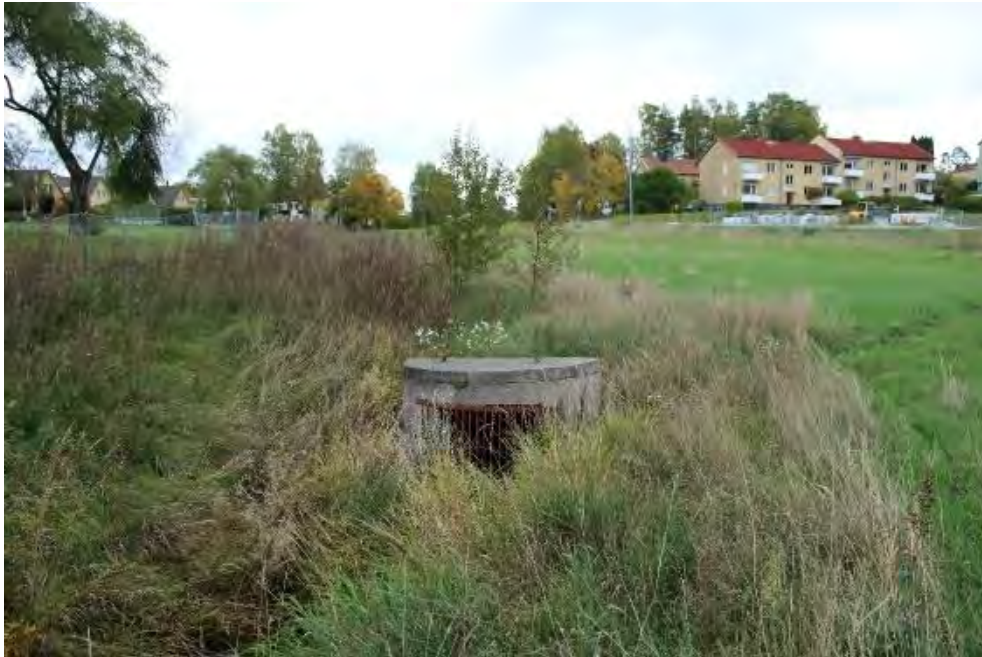
Figur 148. Valasjögraven rinner in i sin kulvertering vid Sällskapsvägen. Hur kulverteringen sträcker sig under jord är oklart.
