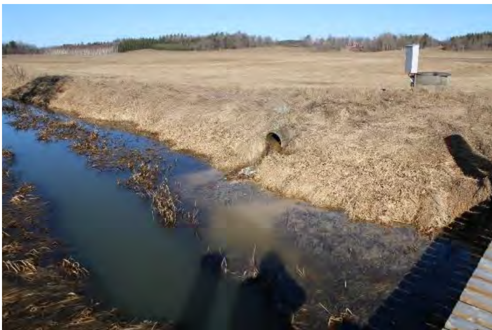
Figur 155. På sträckan upp mot Vadsbro mynnar flera täckdiken vilka för med sig sedimentrikt vatten.
