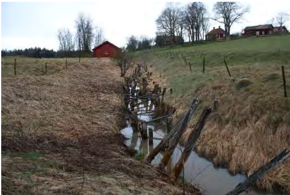
Figur 46. Vid Harlinge blir vattendraget återigen svagt strömmande med låg beskuggning. På bilden syns en mängd pålfundament som står i åbänken och i vattendraget. Pålningen kan ha skett i syfte att få vattendraget att inte kalva ut i fåran.
