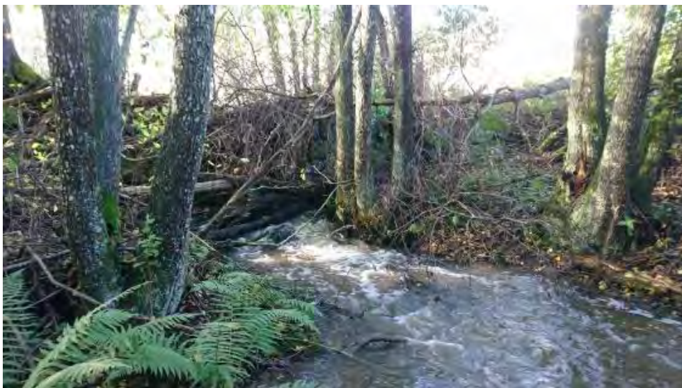
Figur 81. En bit uppströms väg 224 sträcker sig en drygt två meter hög fördämningsvall/överfart över vattendraget. Denna vall bedöms vara ett definitivt vandringshinder.
