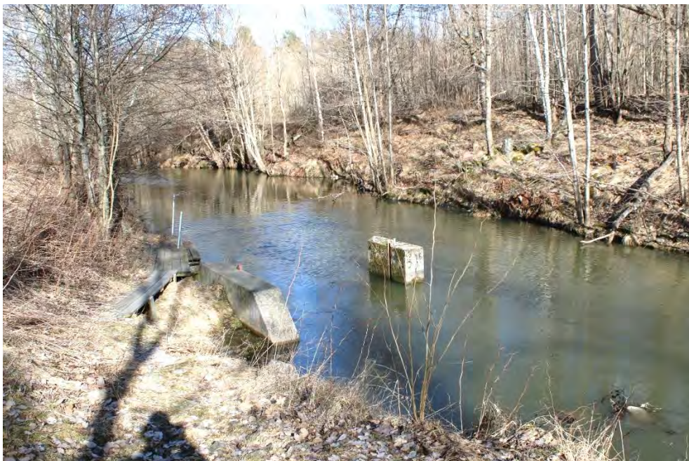
Figur 133. Vid Lilla Sigtuna finns en betongkonstruktion med en tvärgående betongbalk i botten vilken är Frösjöns nivåreglerande sjötröskel.
