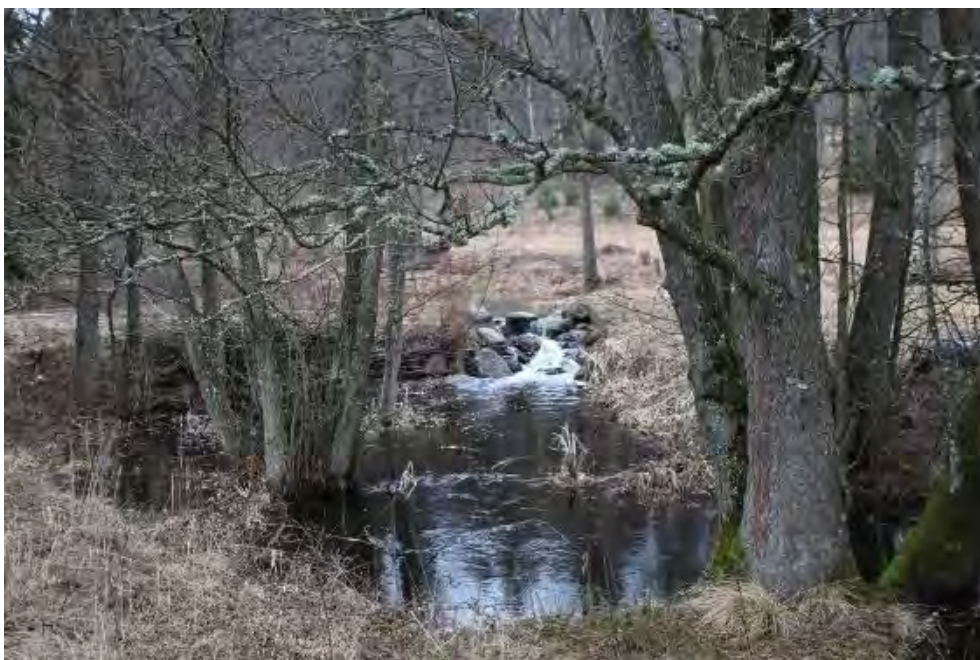
Figur 117. Det första dämnet upp mot Dammen består av ett dämme av block som dämmer tre mindre vattenspeglar. Dämnet är ett vandringshinder för fisk.
