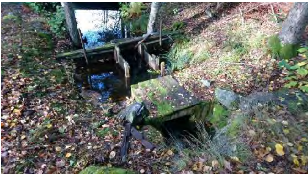
Figur 75. Tomtsjön regleras via ett överfallsvärn.
