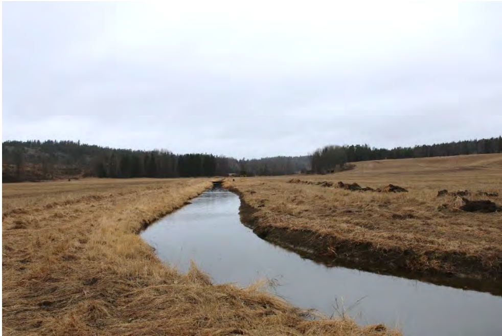
Figur 111. På sträcka 1 vid Långbro är vattendraget kraftigt rätat och fördjupat och saknar kantzoner.
