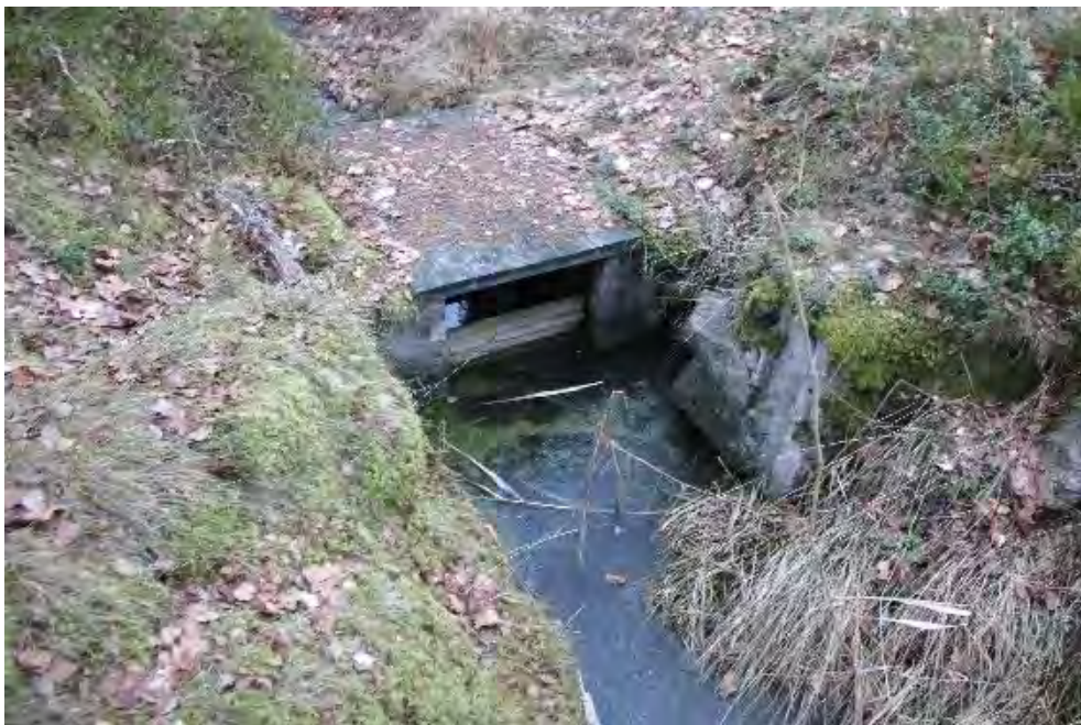
Figur 71. Hedsjöns utlopp till Malmsjön sker igenom en kortare dikes/bäckfåra. Sjön har sänkts genom att det sprängts en fåra i berget. Sjön regleras via ett överfallsvärn med träsättar.
