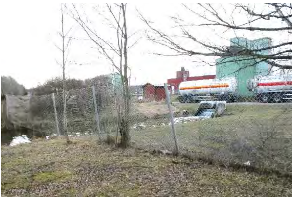
Figur 134. Sigtunaån är recipient för Gnestas reningsverk vilket släpper ut renat avloppsvatten ungefär mitt i Sigtunaåns sträckning.
