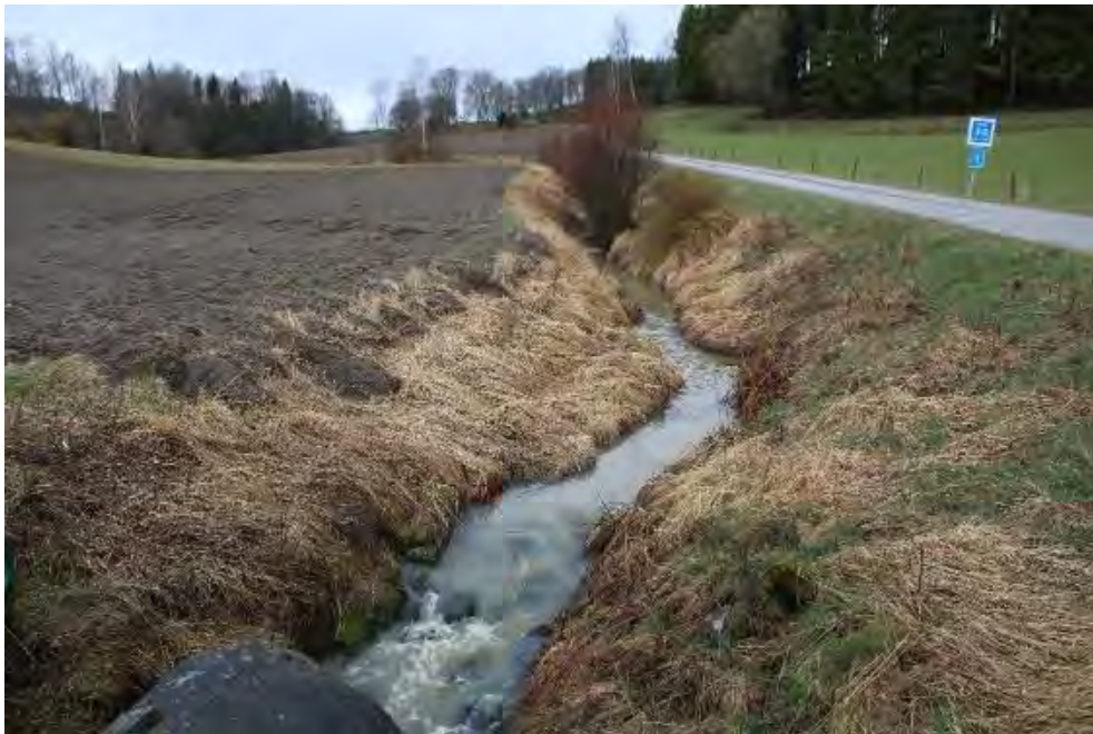
Figur 44. Uppströms väg 224 blir vattendraget svagt meandrande med högre vattenhastighet.
