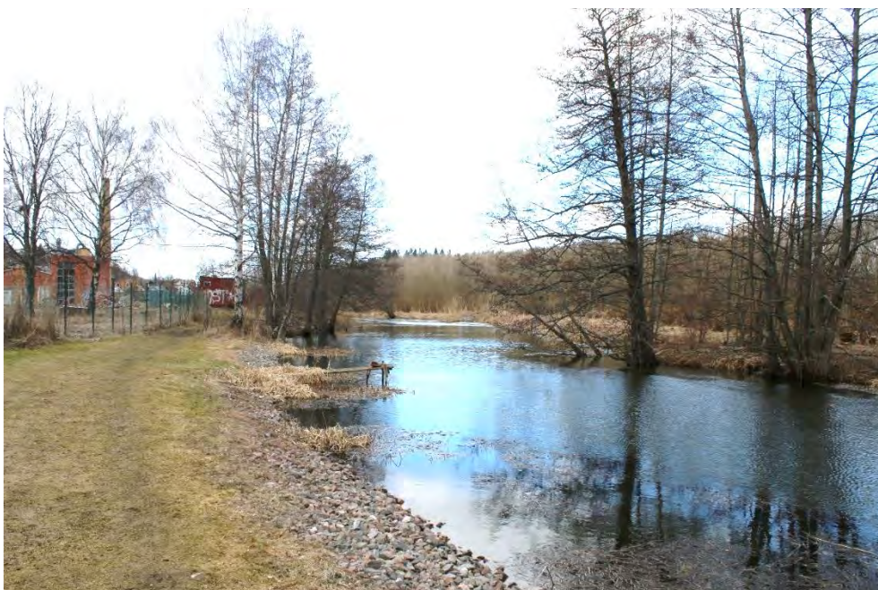
Figur 136. Uppströms reningsverket har Sigtunaån erosionsskyddade kanter av bergkross längs med dess västra sida. Beskuggningen är generellt låg längs med hela sträckan från reningsverket upp till Frösjön.
