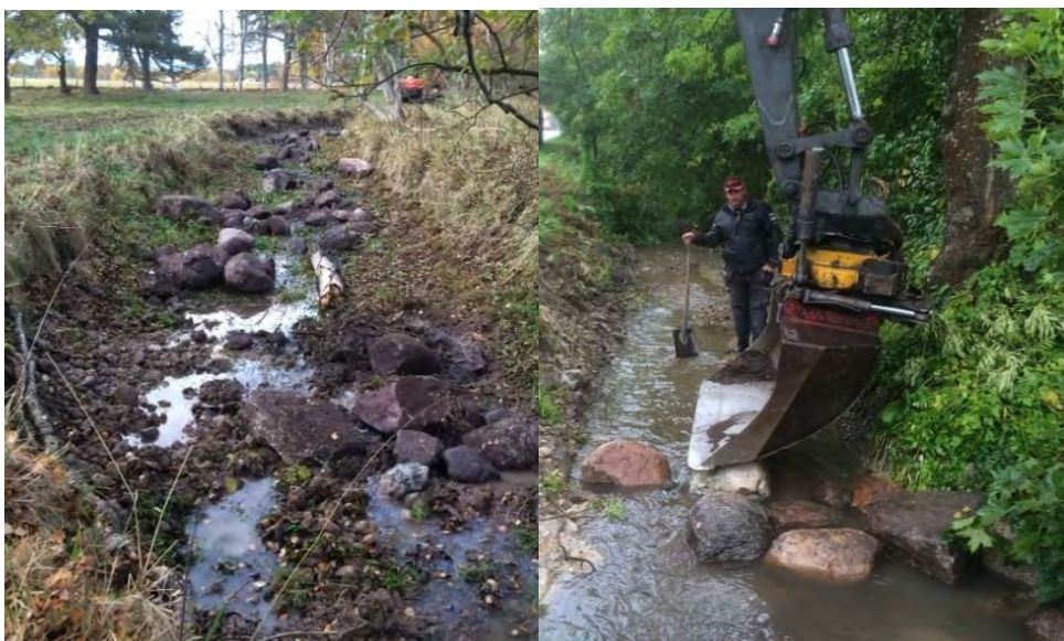
Figur 15. Utläggning av större stenar och grus i strömmande vatten är exempel på åtgärder som skapar turbulens, lek- och uppehållsplatser för fisk och en allmänt högre variation i vattendraget. Foto: Lars Vallin
