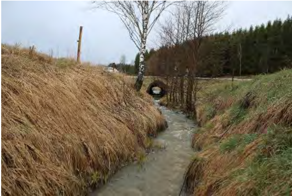
Figur 43. När huvudfåran viker av uppåt i avrinningsområdet under väg 224 ökar vattenhastigheten och botten blir hårdare med inslag av block och sten.
