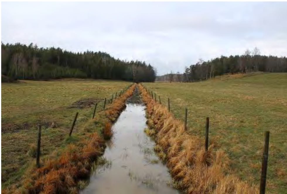
Figur 47. Strax uppströms Harlinge gård förgrenar sig vattendraget i två fåror. På bild syns biflödet mot Gärssjön vars bladvassbälten kan anas överst i bild. Biflödet är kraftigt rätat och rensat utan beskuggning. Biflödet är fritt från vandringshinder.
