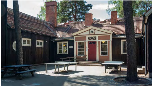
Referens förskolan, i korsningen Stensundsvägen och Krymlavägen.
