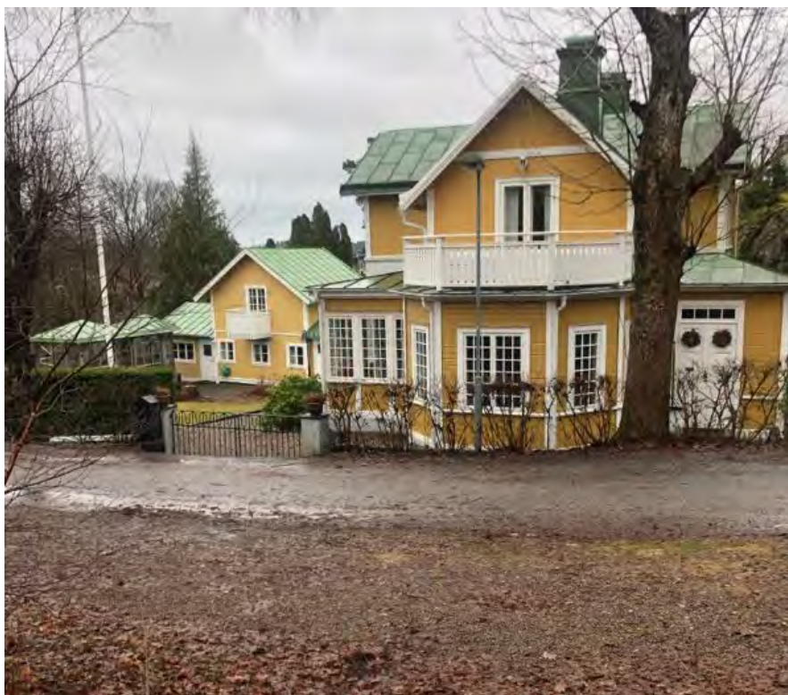
Bebyggelse på fastighet Rönnebo 2 och Alpgatan sett norrifrån. Planområdet syns i förgrunden.
