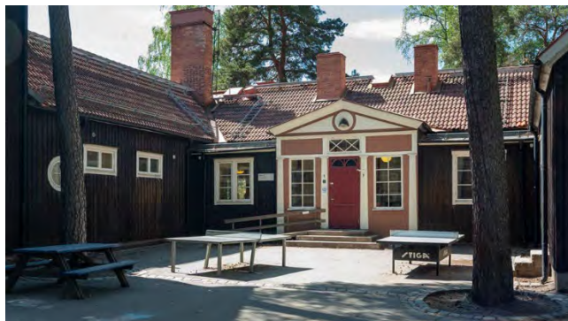
Referens förskolan, i korsningen Stensundsvägen och Krymlavägen.
