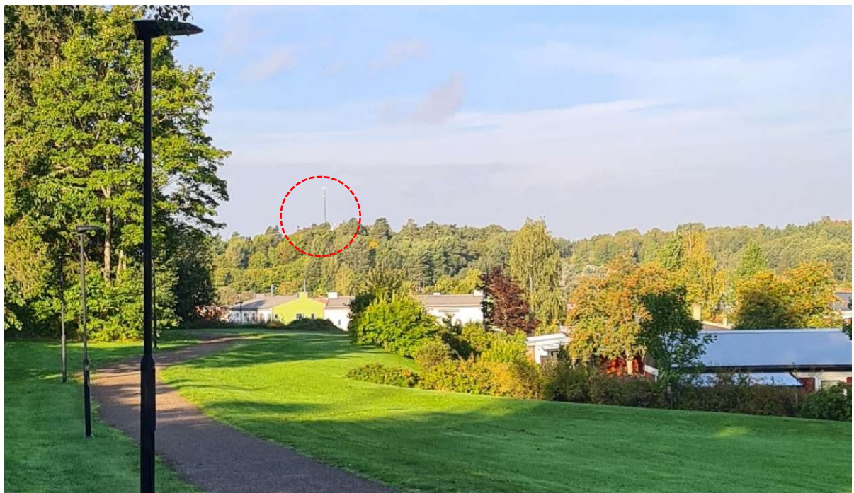
Vy mot detaljplaneområdet. Inringat i bilden vattentornet som knappt syns ovanför träden samt intilliggande master.
