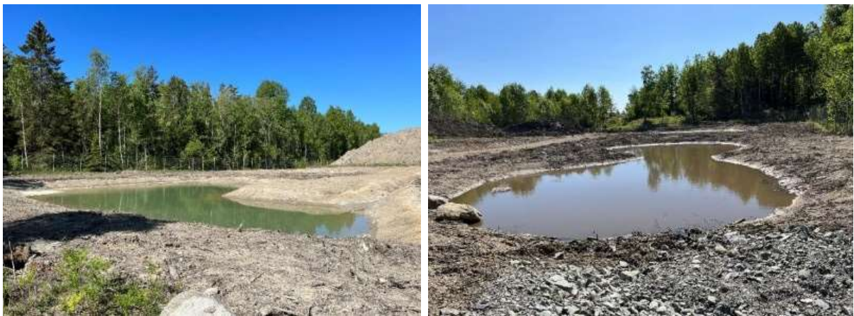
Befintliga dammar i detaljplaneområdets sydvästra del, bilder ur dagvattenutredning.
