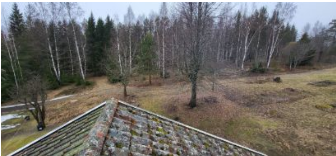
Vy från södra bostadshusets tak mot trädgårdar och vägslinga i väster.
