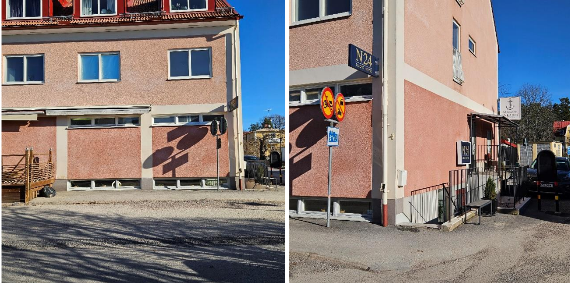
Figur 8 och 10 På bilderna ovan visas fönstren till frisörsalongen i källarlokalen. Till höger visas även trappan ner till frisören.
