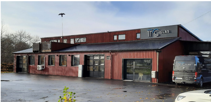
Befintlig verksamhetsbyggnad inom Trosa 11:6.
