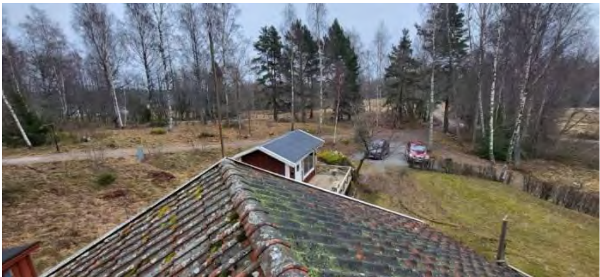
Vy från södra bostadshusets tak mot infarten i sydost.
