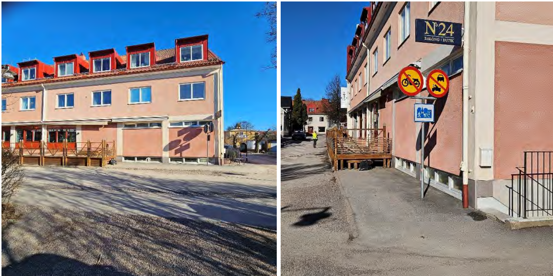
Figur 7 och 8 Bilderna ovan visar den befintliga byggnaden med tillhörande uteservering lokaliserad på trottoaren. I förgrunden till höger syns även vägmärken som förbjuder motortrafik i området.
