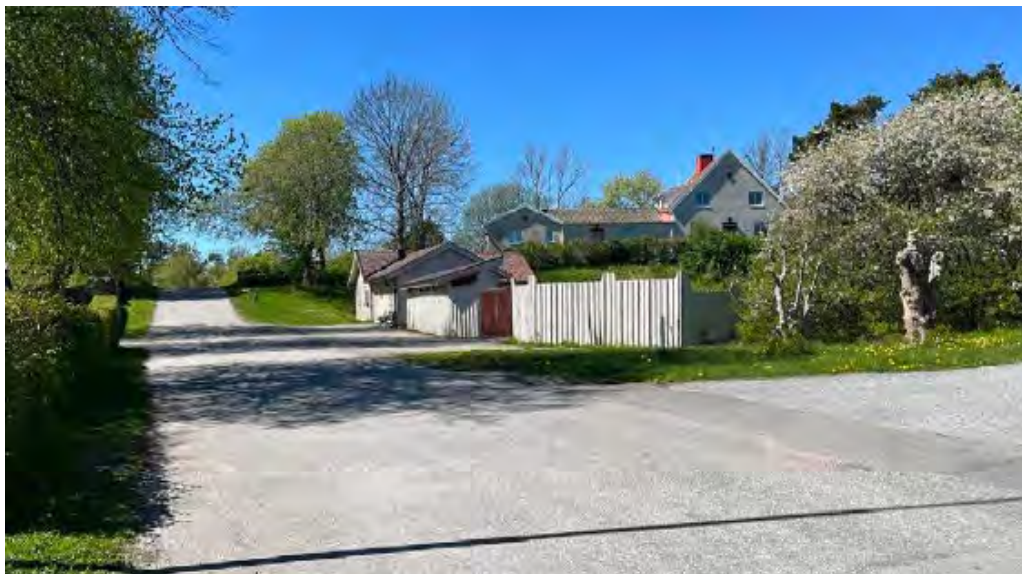
Vy över fastighetens södra delar mot Östra Kyrkvägen (Bild: AIX Arkitekter).
