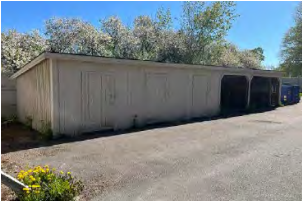
Förrådslänga i östra delen av fastigheten (Bild: AIX Arkitekter).
