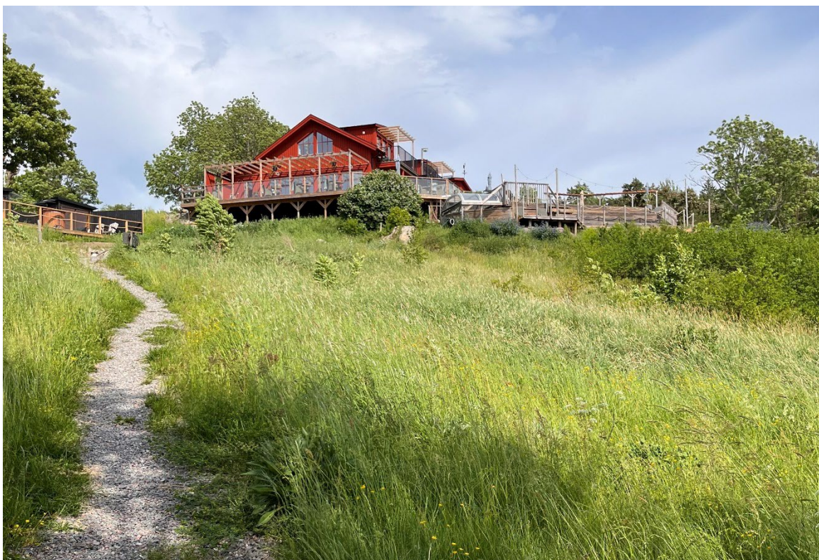
Befintlig stig ner till vattenområdet och bryggan.
