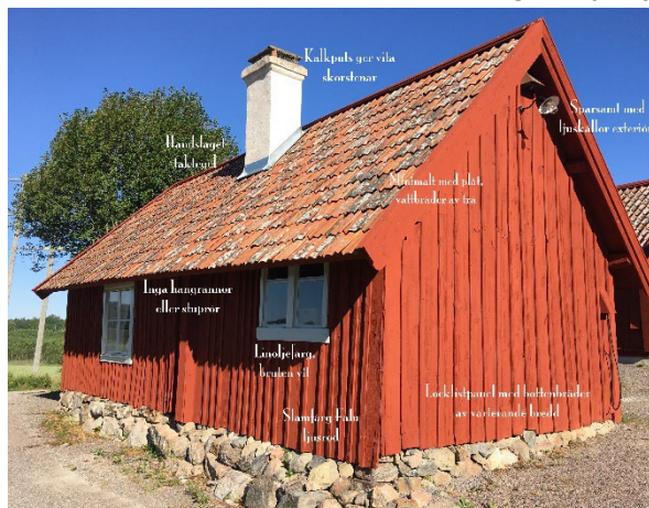
Bild på en av torpstugorna efter renovering.
