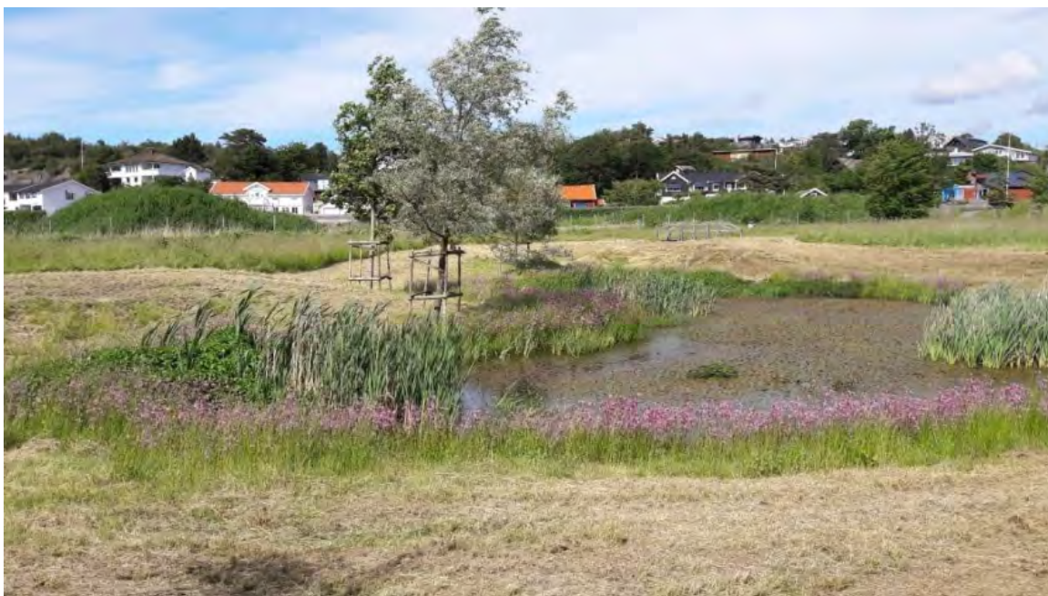
Exempel på dagvattendamm. Bild: Norconsult Sverige AB
