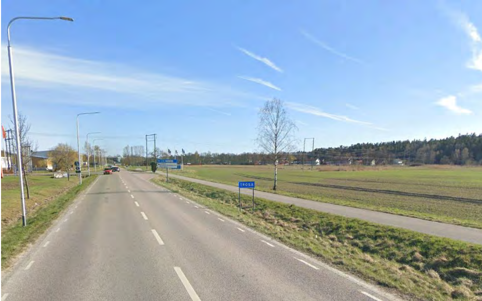
Figur 28. Väg 218 utmed detaljplanens östra gräns.
