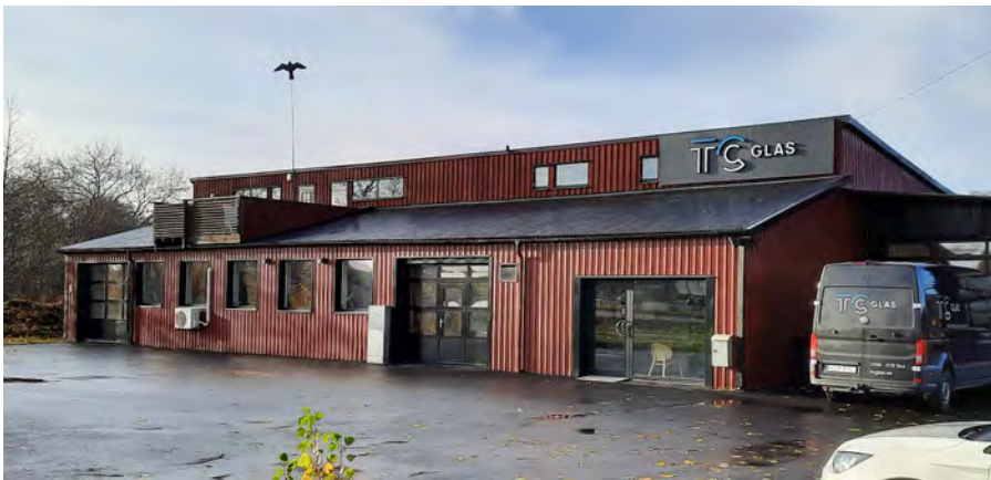
Befintlig verksamhetsbyggnad inom Trosa 11:6.
