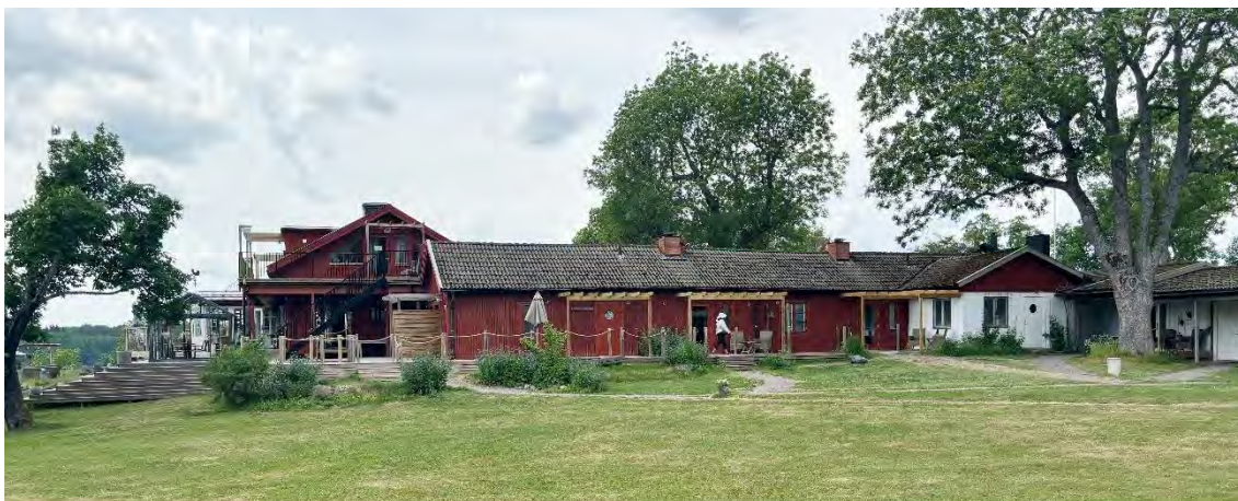
Till vänster hotellets huvudbyggnad som är sammankopplad med lägre byggnader i vinkel.
