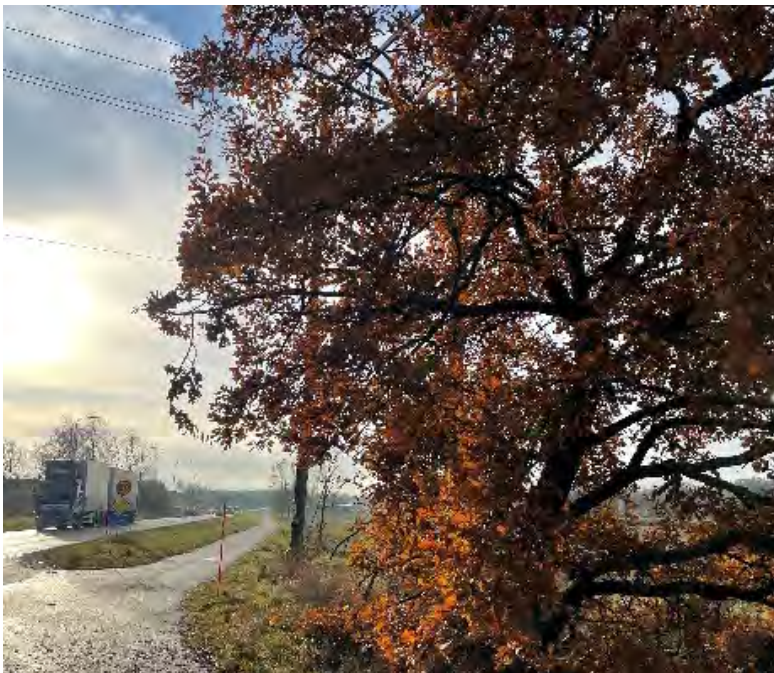
Växtlighet i anslutning till kraftledningen längs med väg 218.
