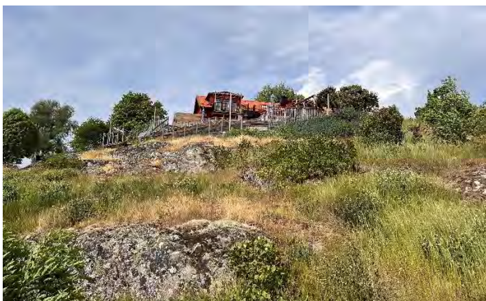
Fastigheten är belägen på en höjd ovanför sjön Sillen.
