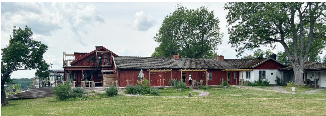
Till vänster hotellets huvudbyggnad som är sammankopplad med lägre byggnader i vinkel.
