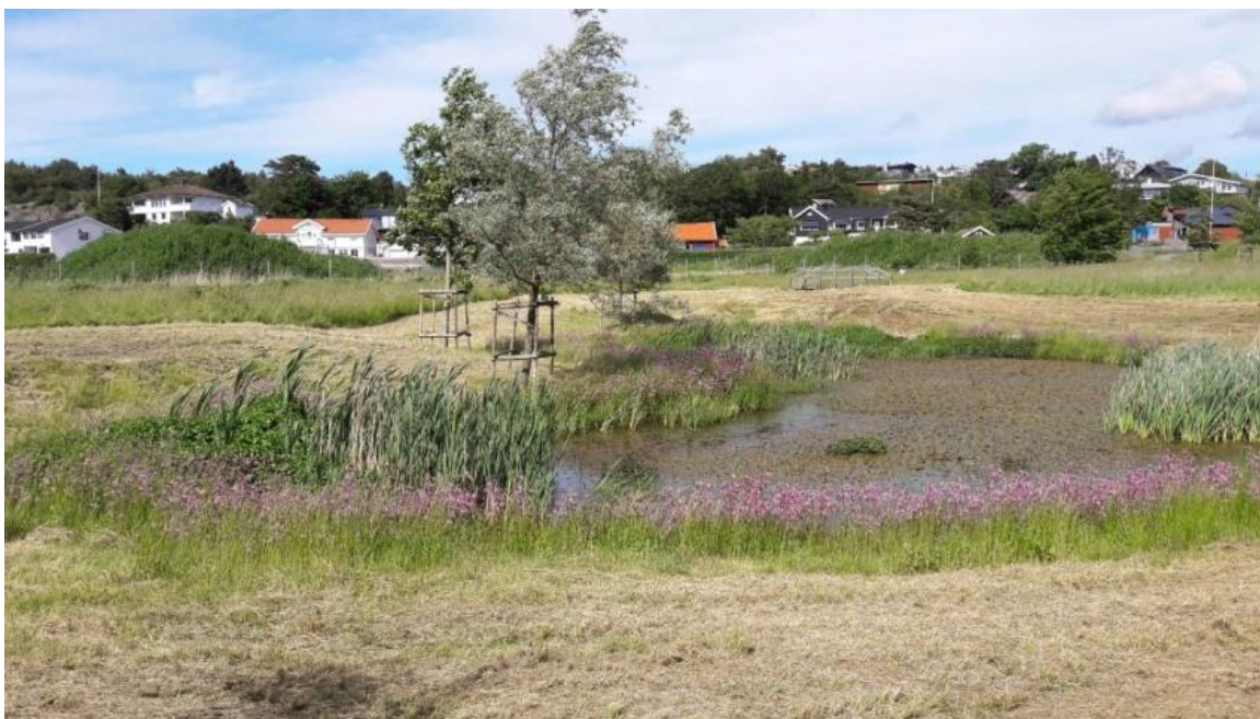
Exempel på dagvattendamm. Bild: Norconsult Sverige AB
