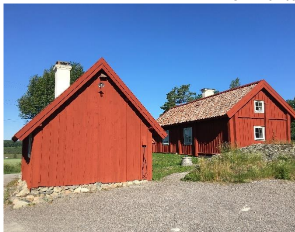
Bild på de renoverade torpstugorna som ligger i sydöstra delen av planområdet.
