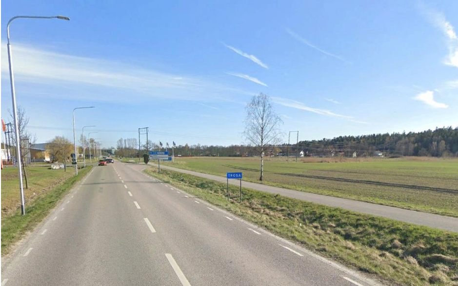
Figur 28. Väg 218 utmed detaljplanens östra gräns.
