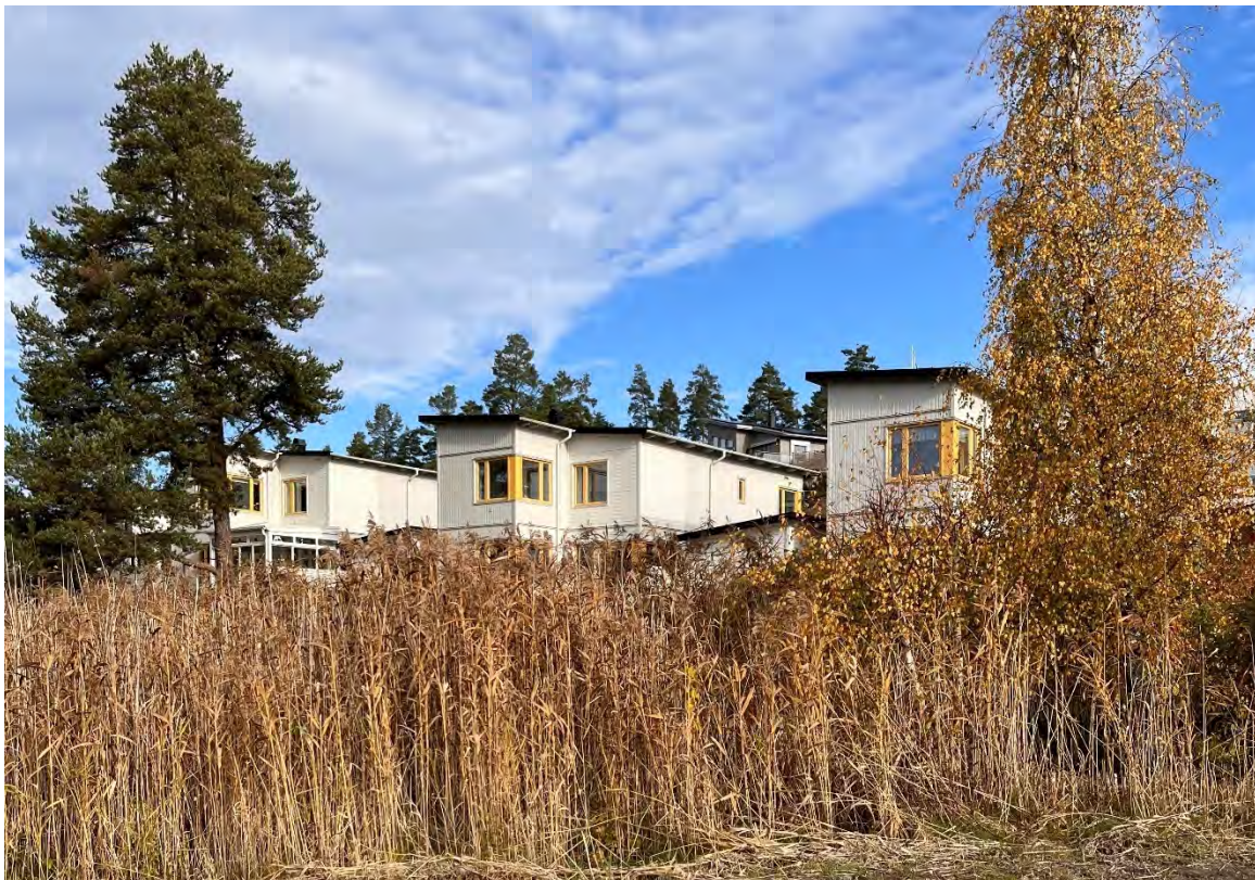
Befintliga kedjehus längs med Skogstigen, sett från Gunnarstensgatan.
