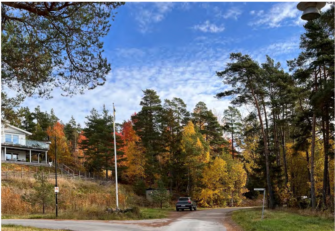
Befintlig bebyggelse som vetter mot planområdet, korsningen Sjölundavägen, Skogsstigen och Gunnarstensgatan. Planområdet syns delvis till höger i bild.
