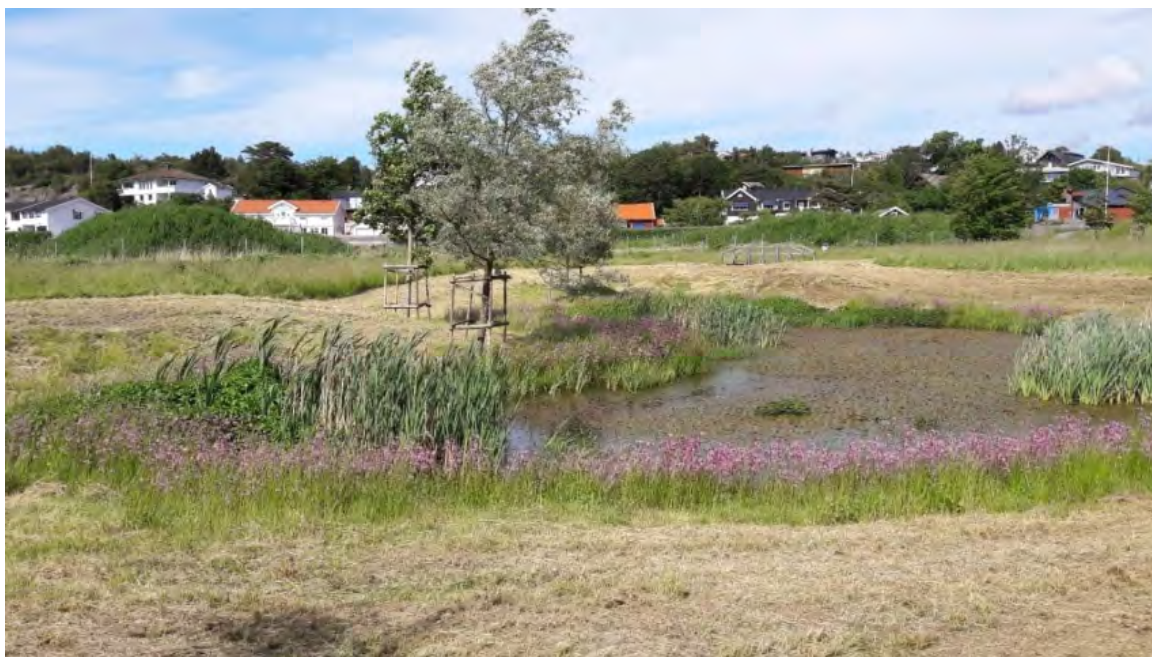
Exempel på dagvattendamm. Bild: Norconsult Sverige AB
