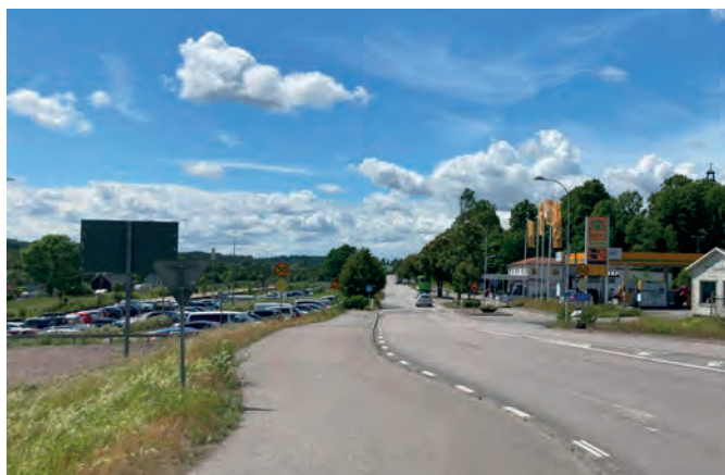
Den första delen av Stationsvägen i östra Vagnhärad saknar gatuträd vilket ger ett glest intryck och skiljer sig från den rumsliga inramningen som vägen har lite närmare stationen.
