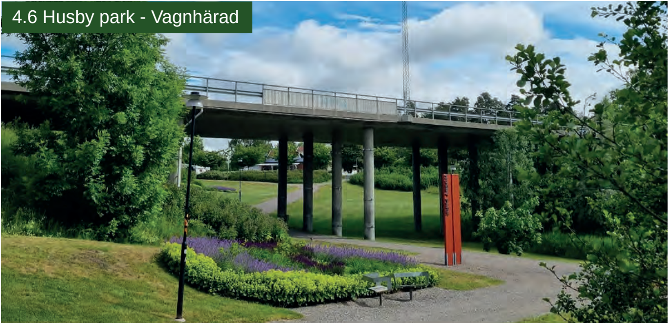
Finplanteringar och sittplatser invid pelaren med parkens namn och slänten upp mot Gamla vägen. Brons öppna lätta konstruktion blir som ett element i parken och bidrar till att länka samman parken på båda sidor om bron.
