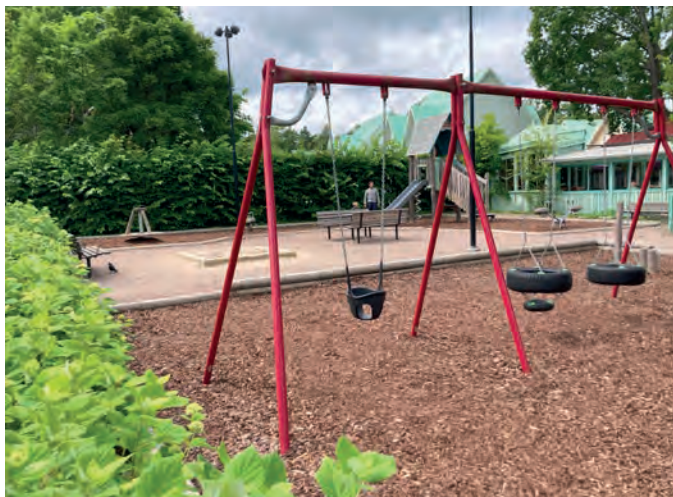
Gungor med fallskydd av bark i lekplatsen.
