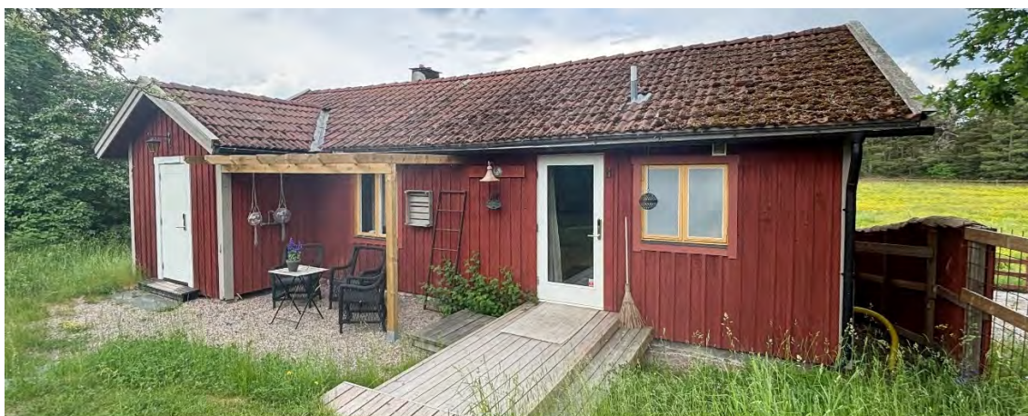
Fristående byggnad för hotellverksamhet.
