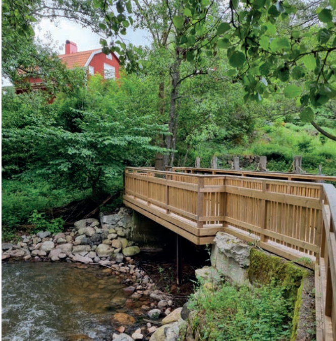
Dammen/bron med bryggan som går ut över ån.
