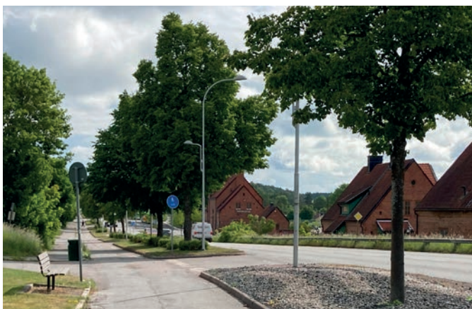
Den östra entrén till Vagnhärad längs Stationvägen är en långsträckt allé med lindar med ytor av ölandstok eller olikfärgat grus. En upprustning av buskytorna kring träden kan ge ett mer enhetligt och omhändertaget uttryck.
