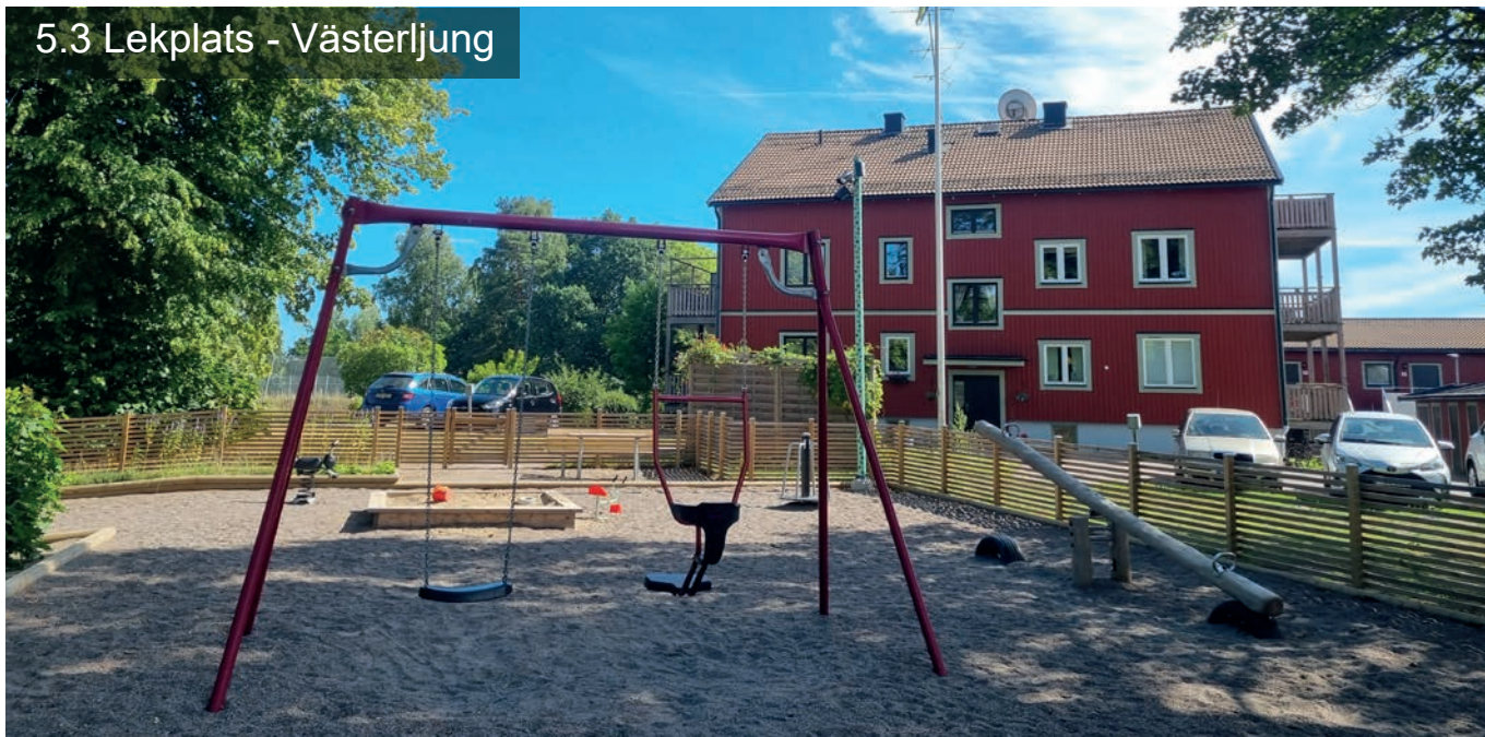
Bostadshus bakom lekplats sett norrifrån.
