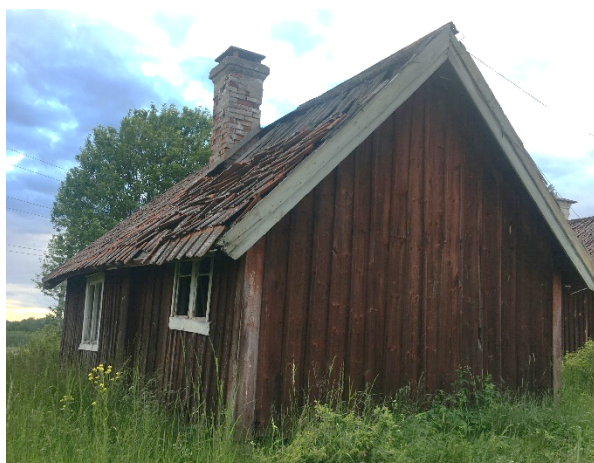
Bild på en av torpstugorna innan renovering.
